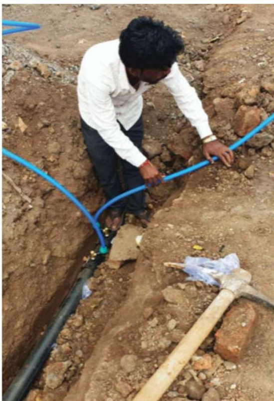
निर्माणाधीन डिस्ट्रिब्यूशन पाइप लाइन कार्य एवं इलेक्ट्रो-फ्यूजन शैडेल द्वारा घरेलू-नल कनेक्शन कार्य आवर्धन जल प्रदाय योजना, गुना (म.प्र.)
